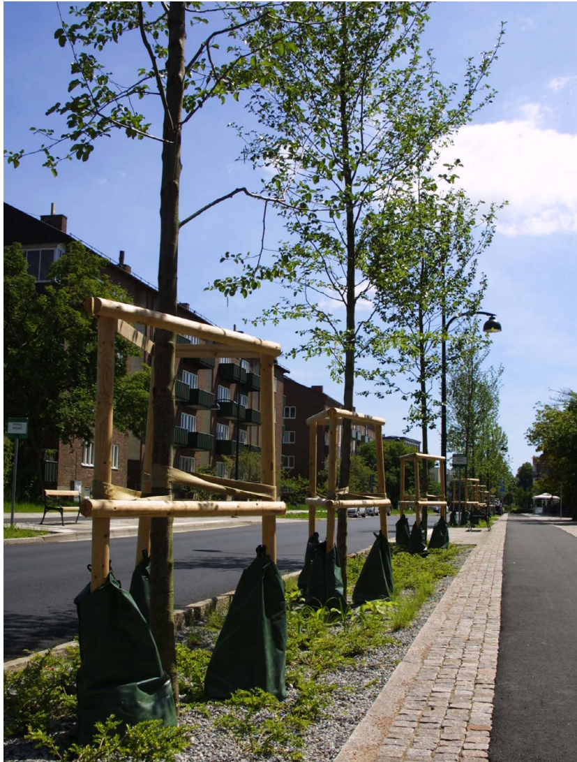
Figur 4.2. Byggmästaregatan i Lund. En konstruktion med gatuträd där biokol används i växtbädden för att hålla kvar och rena vattnet åt träden. Foto: María Ingimarsdóttir
